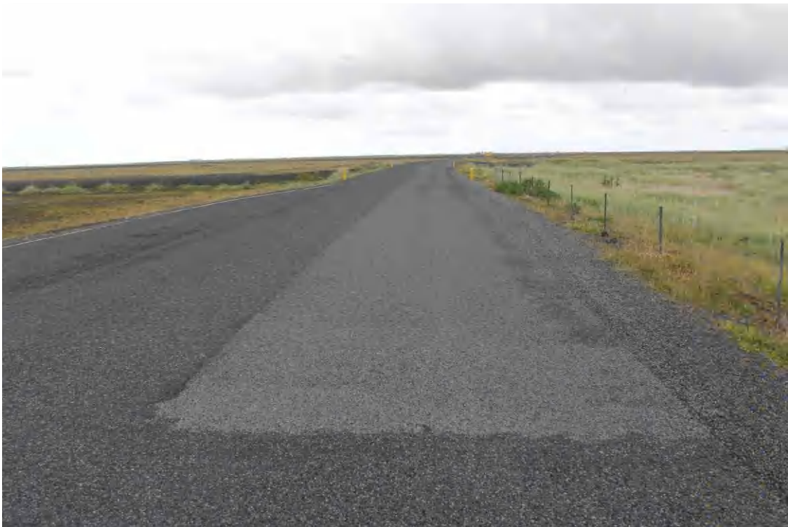
Mynd 12 Skipt er um steinefni á hægri akrein frá stöð 8574, en þar tekur við Ísakotsefni
