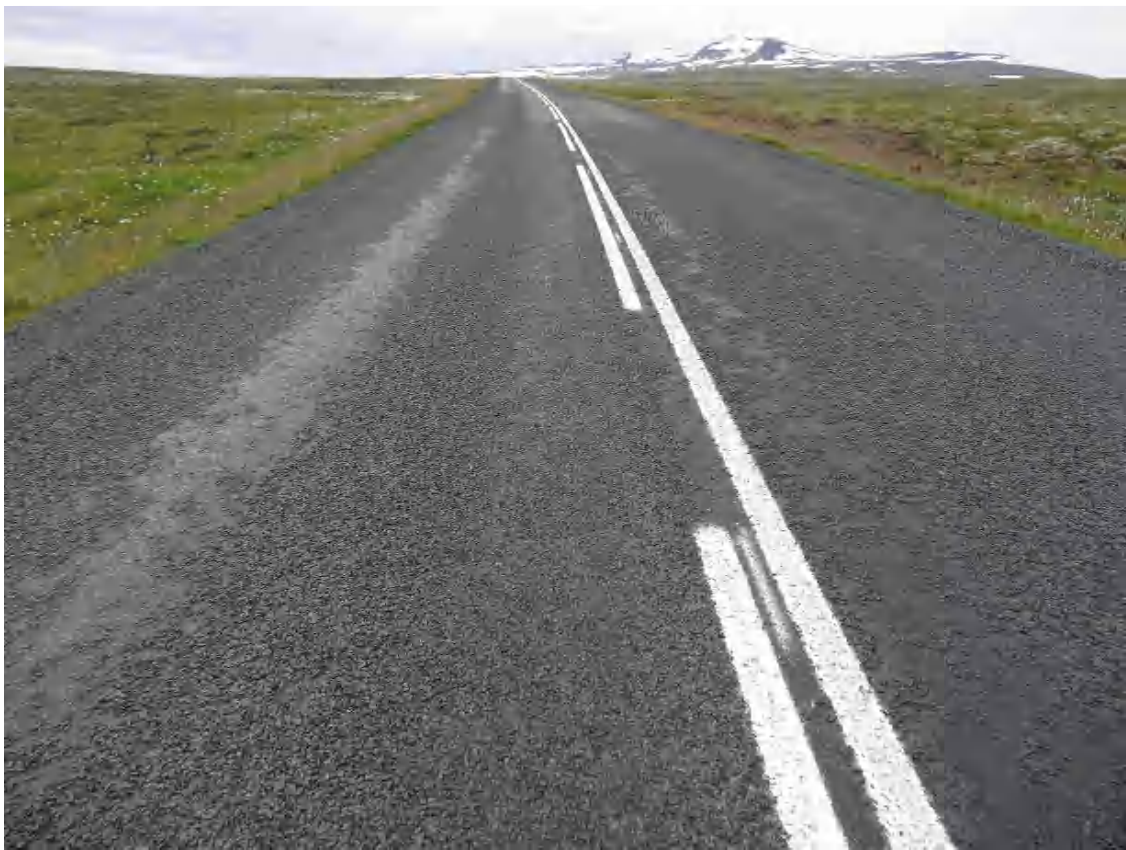
Mynd 21 Yfirlitsmynd af kaflanum í Miklagili horft til suðurs síðustu metrana
