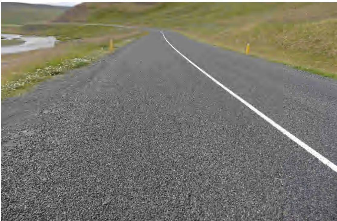
Mynd 41 Steinefnakápan er samfelld í stöð 1463 en ekki sést í bindiefnið
