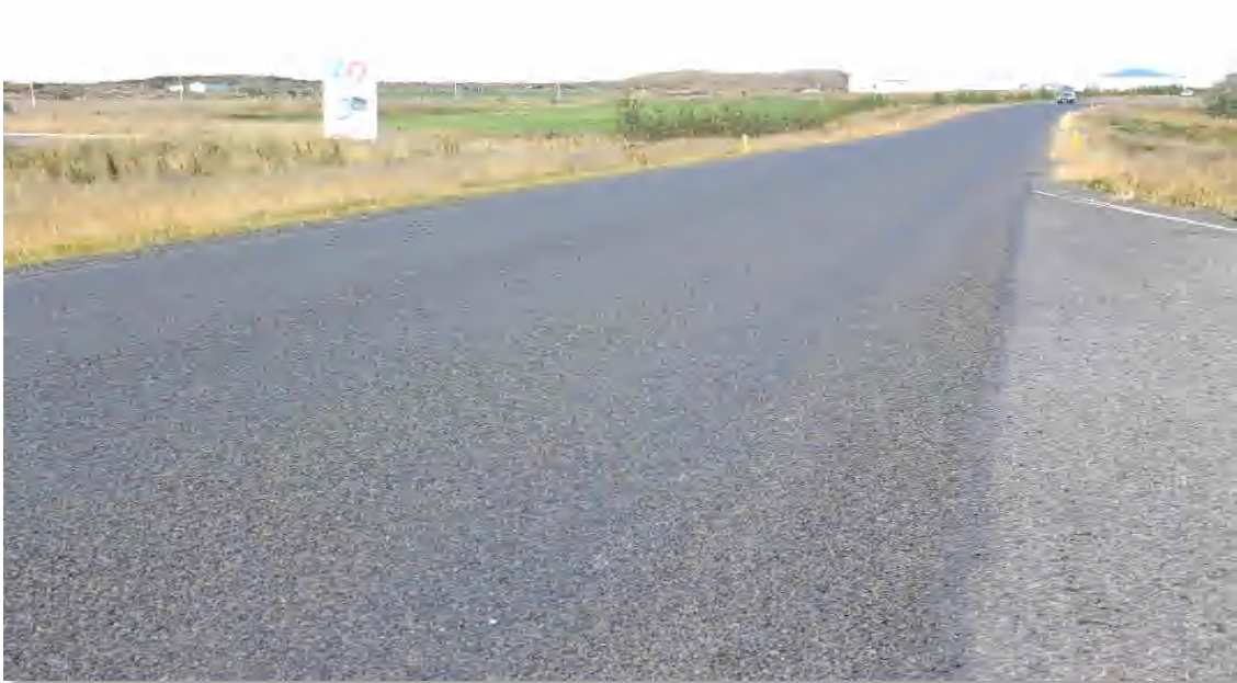
Mynd 50 Klæðingin lítur vel út í stöð 820 þó er lítilsháttar steinlos á saum sjáanlegt
