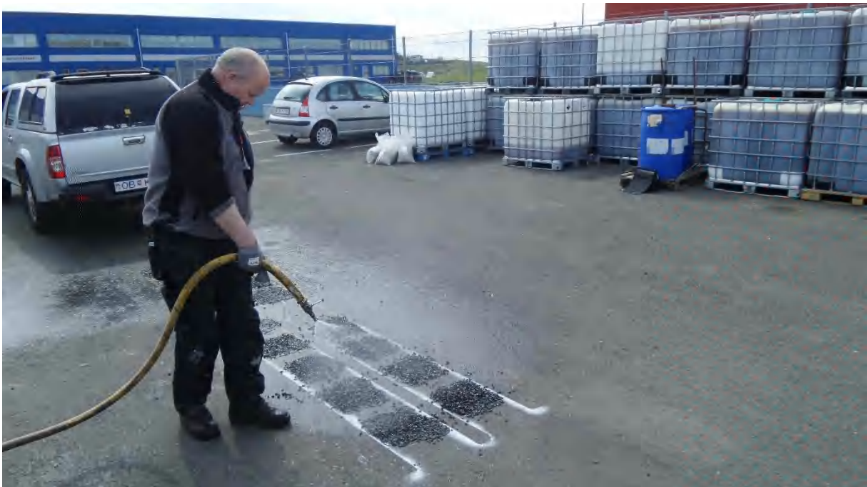
Mynd 7 Vatni sprautað á fletina eftir að allt hafði verið lagt út
