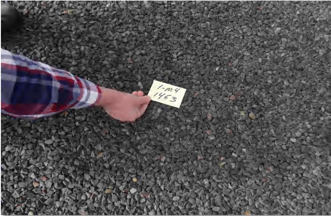
Mynd 40 Nærmynd af yfirborði með 11/16 steinefni úr Neðri-Mýrum á 1-m4 í stöð 1463
