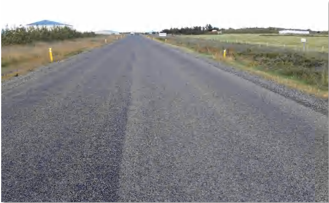
Mynd 52 Biksmit er áberandi á vinstri akrein í stöð 1190, en fer þó minnkandi til austurs
