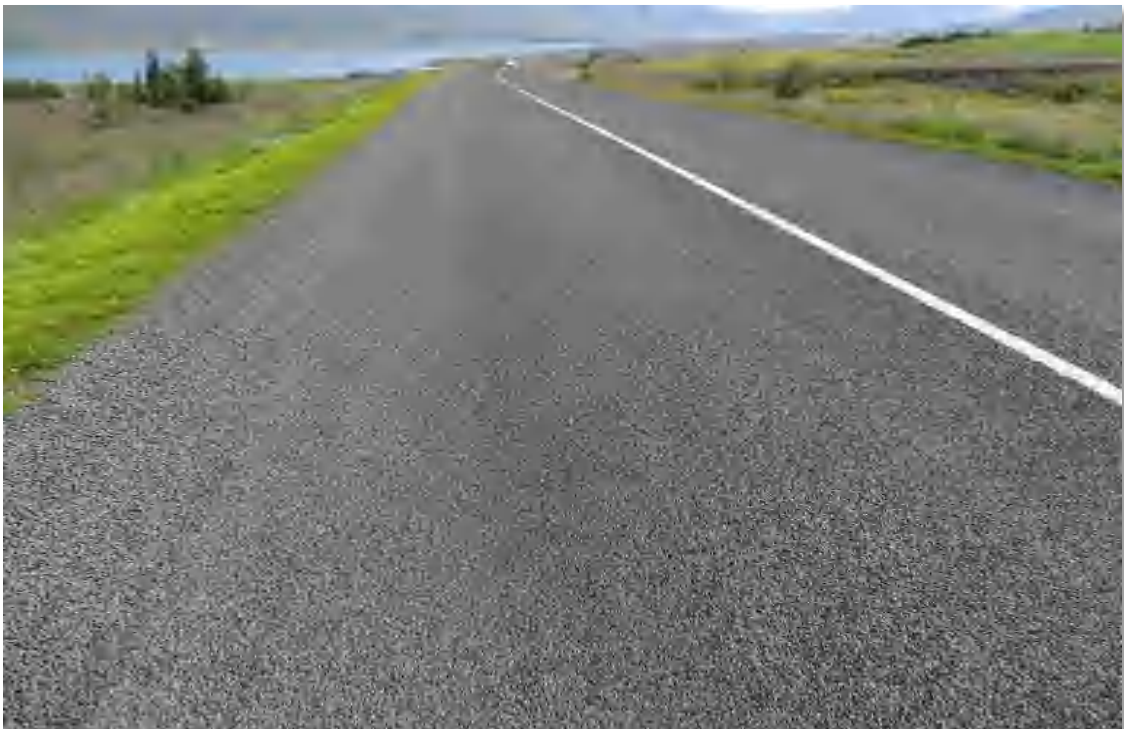
Mynd 43 Myndin sýnir að steinefnakápan er alveg samfelld og sést í bindiefni á milli
