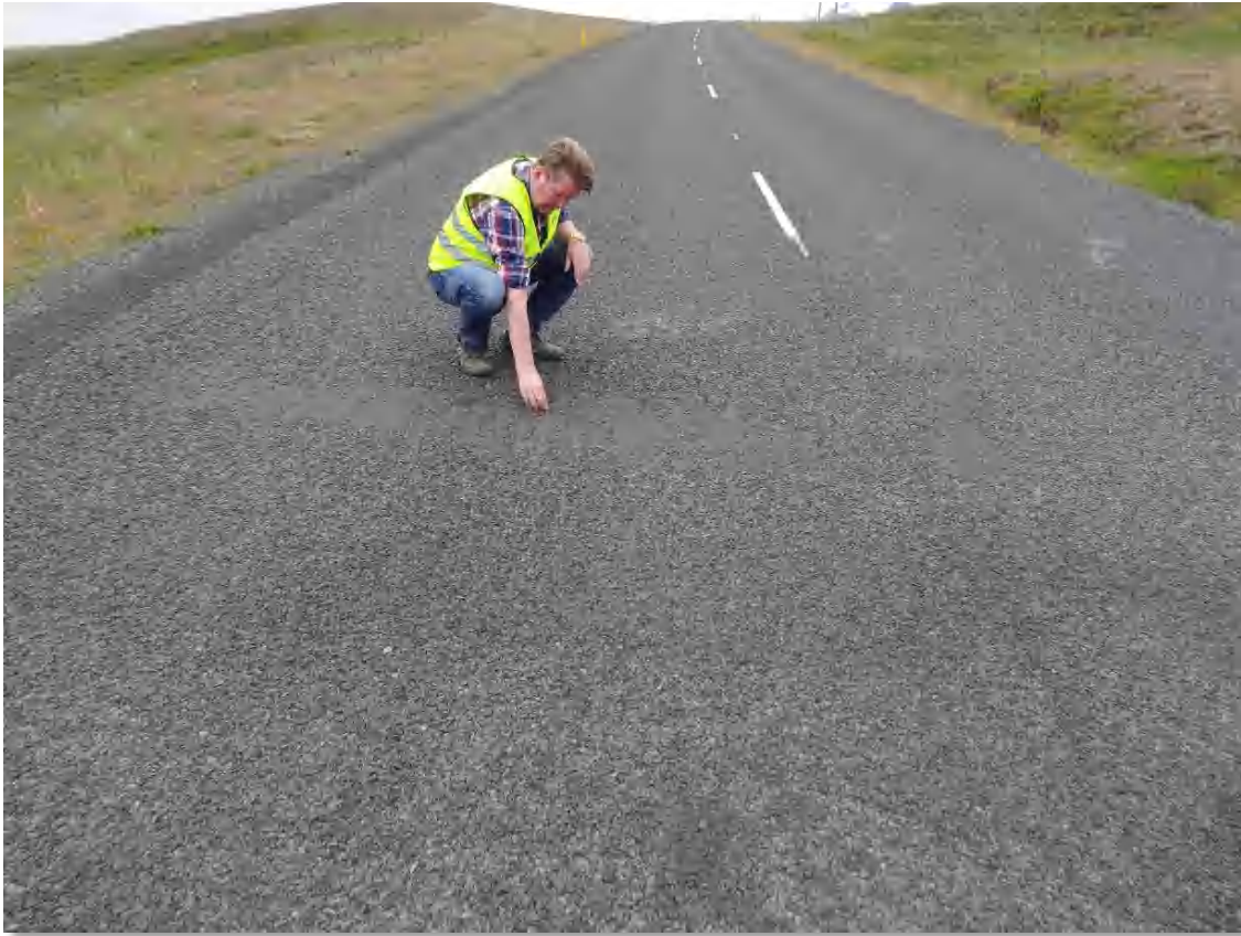
Mynd 28 Skemmd á færuskilum á hægri akrein, hér horft til suðurs frá stöð 2763
