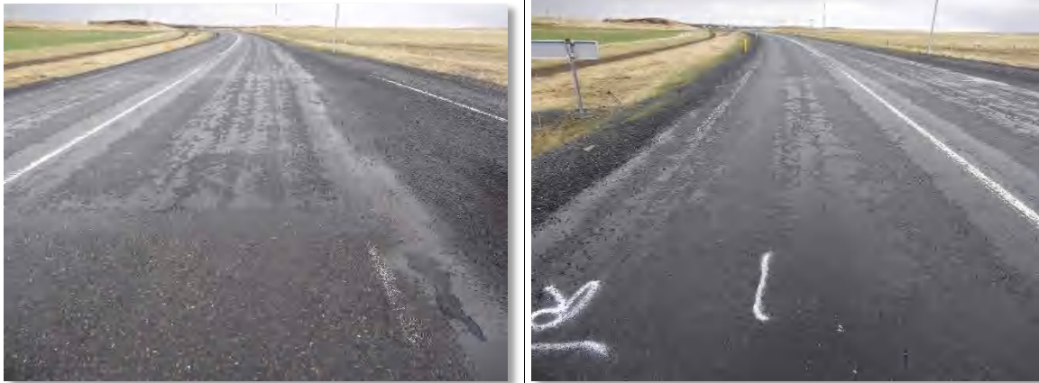
Mynd 74 Mikið steintap var í kaflanum í stöð 9 a) og minna þar sem ralumac er undir b)
