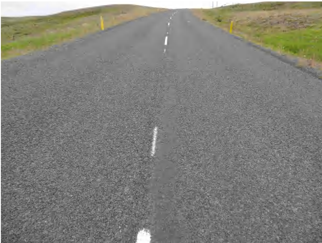
Mynd 27 Svólítið steinlos við saum sést á þessari yfirlitsmynd til norðurs í stöð 2763
