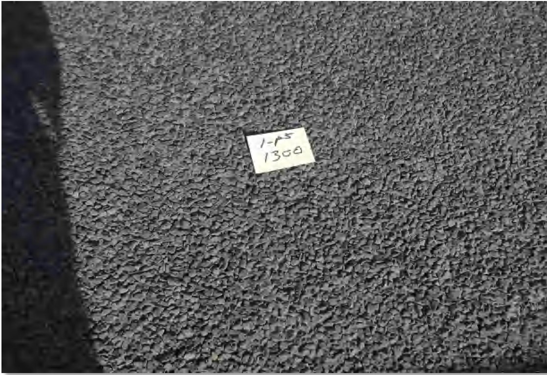
Mynd 44 Nærmynd af yfirborði með 8/11 mm steinefni úr Skútum á 1-p5 í stöð 1300
